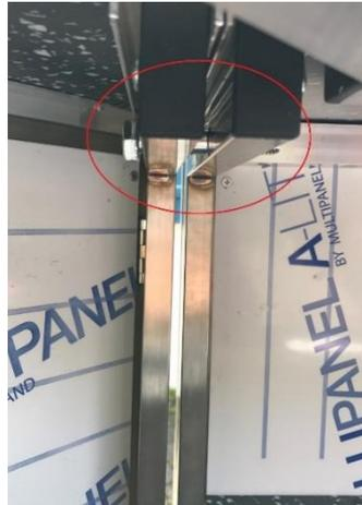
Zum Schluss Eckgestelle am Mittelteil mit je einer großen Schraube links und rechts unterhalb der Thekenbretter befestigen.
